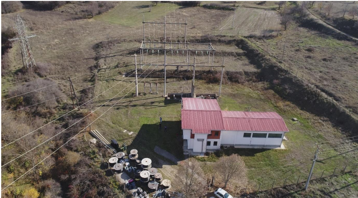
Trafostacion i vogël, po me rëndësi të madhe
