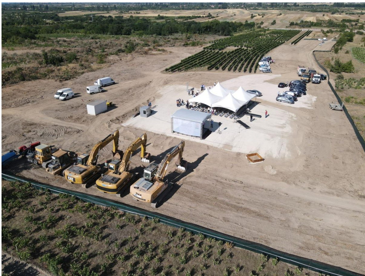
Слика 3. Поставување на камен темелник на 400/110 kV трансформаторска станица во близина на Охрид
