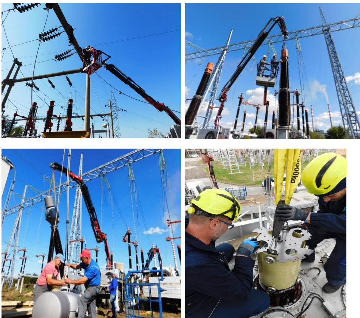
Слика 10. Монтажа на опрема во трансформаторски станици
